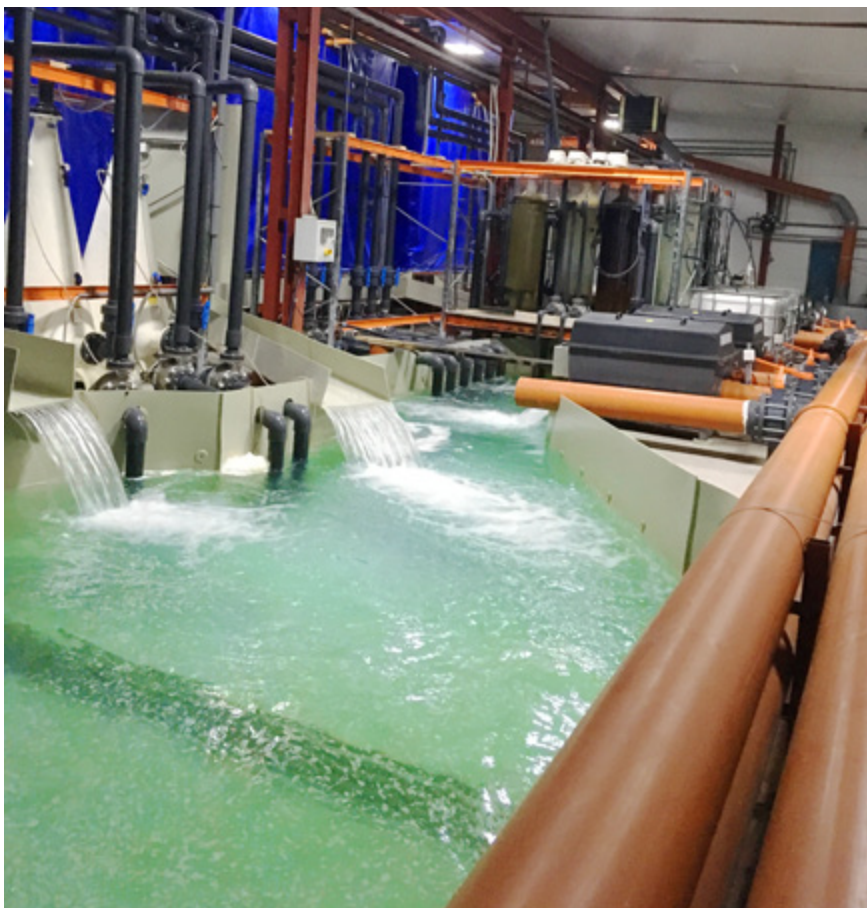
Översikt av en RAS-odling. Det kan krävas stora ytor för att lufta vatten så ha det i åtanke när du planerar för din odling.
